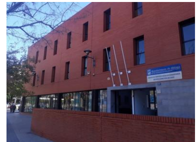
CSSS Distrito Carretera Cádiz
