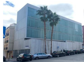
CSSS Distrito Bailen-Miraflores
